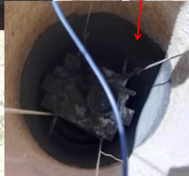
Finition du puits par coulage de ciment sur la paroi intérieure
