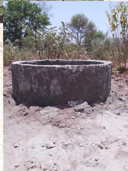
Construction de 11 bassins répartis sur la surface du terrain
