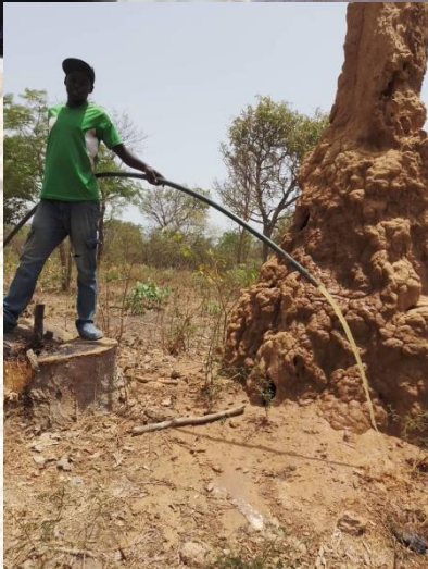
Mise en eau du puits
