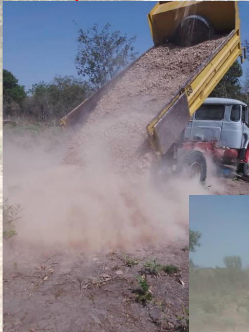
Livraison des matériaux
